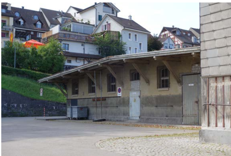
Foto mit Sicht auf einen Teil der Stützmauer.
